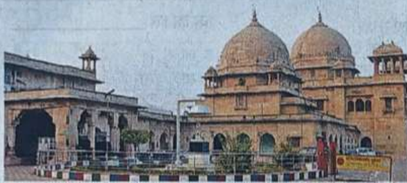
सीएसए भवन • जागरण आर्काइव
